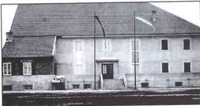
Die historische Barbaraturnhalle wurde 1929 in Betrieb genommen
